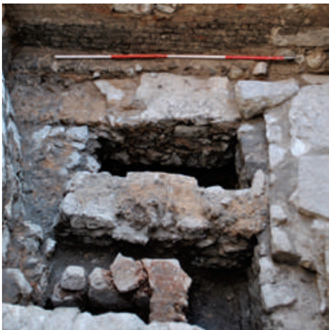
8. Statički zidovi između zvonika i apside crkve / The structural walls between the bell tower and the church's apse (foto: Š. Vrkić)
